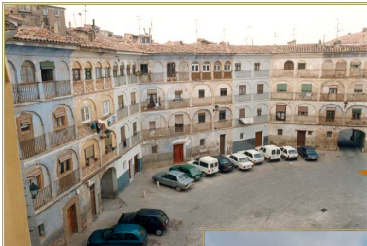
Plaza de Toros Vieja: el antes de la restauración
