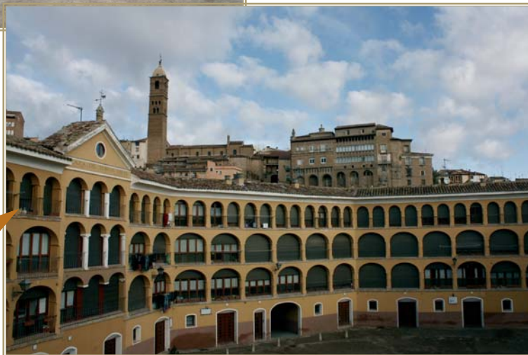
Plaza de Toros Vieja: el después de la restauración
